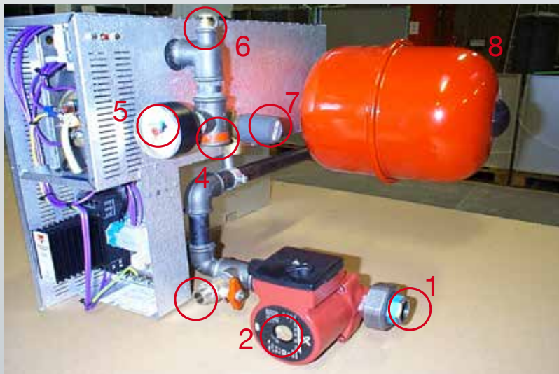
Kuva 22: Sähkökattilan vesikytkentä
